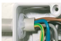
Kaabel kinnitatakse kaabli kinnitusrõngastega
