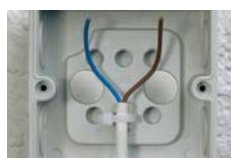
Kaabel kinnitatakse kaablisidemega kaabliklambri külge
